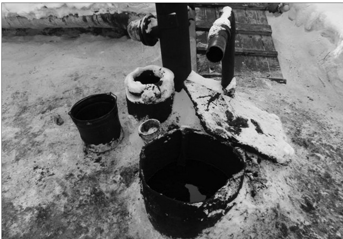
● Котельная в Олекминске, состояние которой внушает опасения жителям города.
